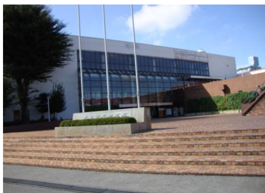
写真3 体育館正面玄関の様子
