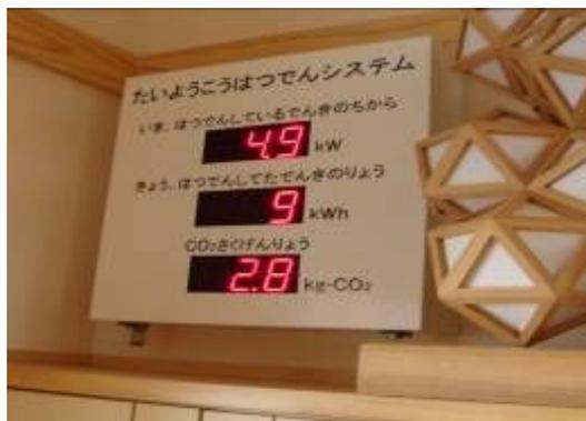
写真 14 発電量などが分かる掲示板
