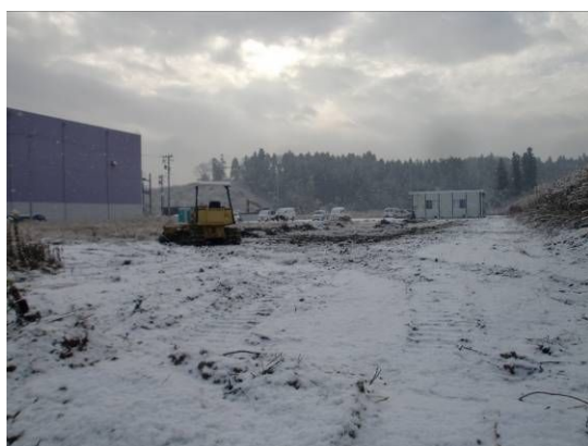
写真 2-6 工業団地内の施設入居予定地
