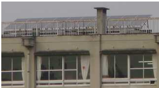
図表 4-1 太陽光発電システムが設置された中学校
