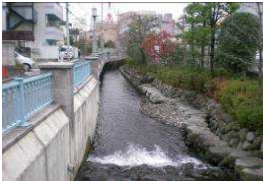
図表 4 - 5 釜川優橋付近(二層構造部分)
