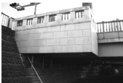
写真6 宮の橋東端北
